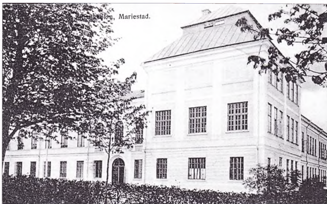
Realskolan i Mariestad fotograferad 1927 av okänd fotograf. Notera den tvåfärgade fasaden. Foto nr: B 145 173:5.
